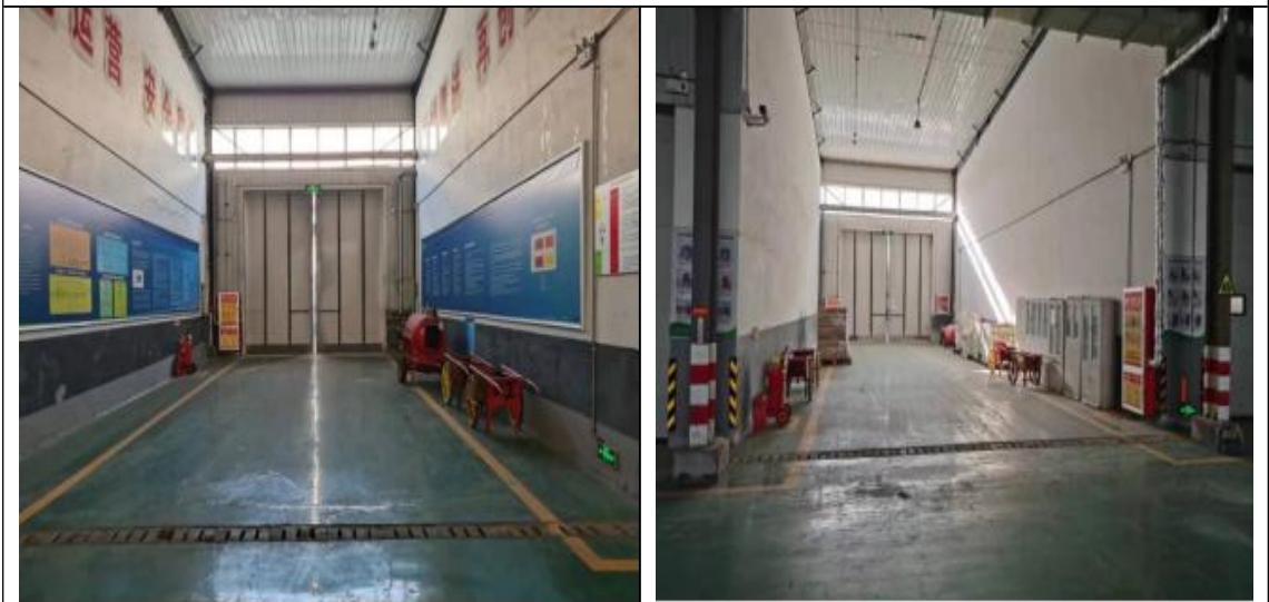
危废暂存库外部
